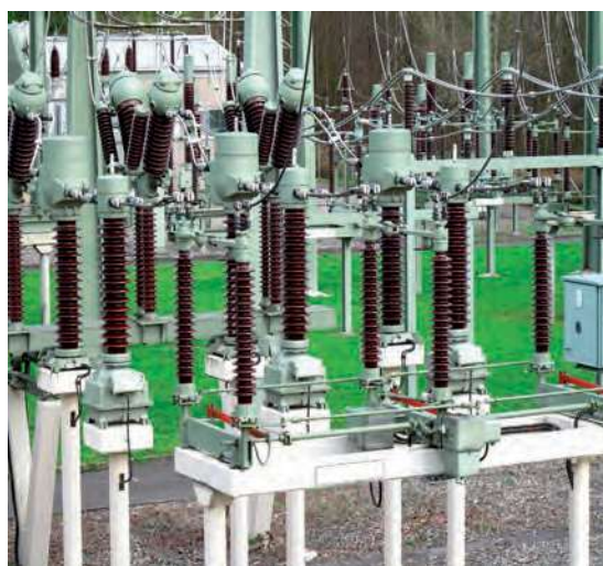
Enchimento seguro e controlado de isoladores de porcelana através da unidade "CommGuard Web"
